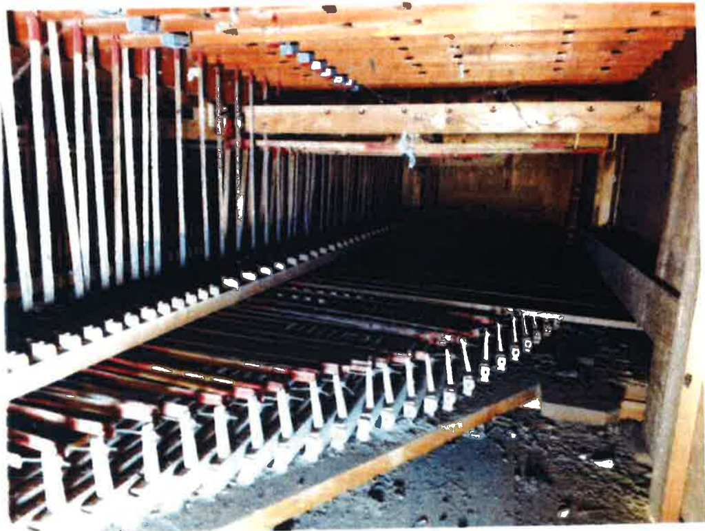
Fot. 09. Widok na mechanizm i spód wiatrownicy manuału.
